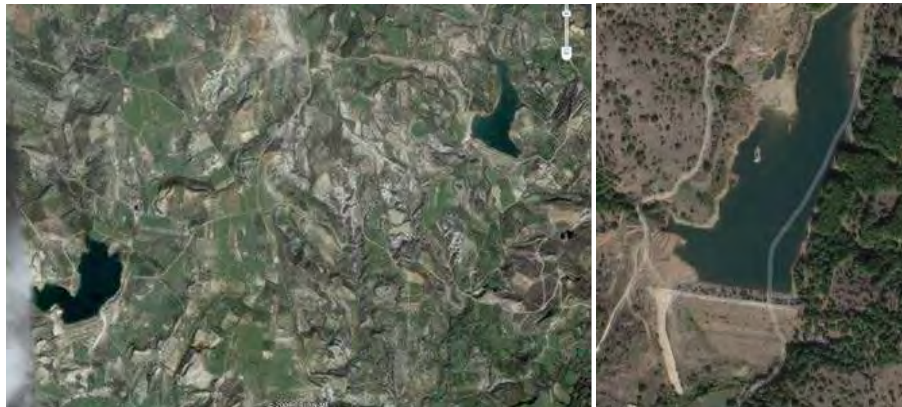
Εικόνα 6. Τα Φράγματα Αμουργελλών (αριστερά) & Παρτίρων (κέντρο) Κρήτης και Γέρμα Καστοριάς Figure 6. The dams of Amourgelles (left) & Partira (center) and Germas-Kastoria
